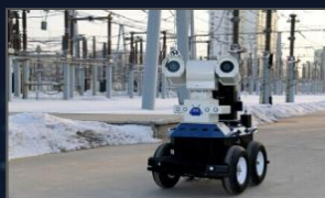
中国 变电站巡检
