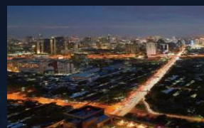
泰国 高可靠电力通信网络
