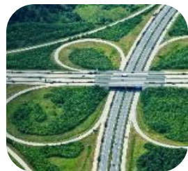
智能基础设施
